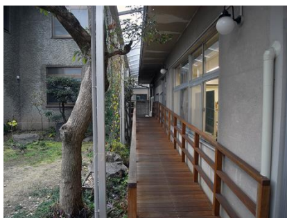
新設されたカフェへのスロープ
